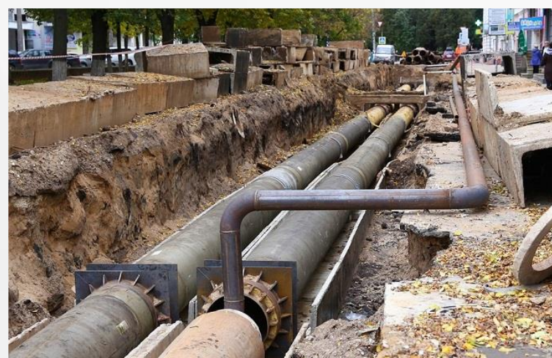
Использовании системного подхода к изучению процесса «старения» трубопровода
